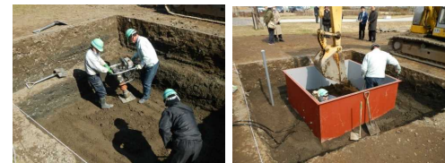
試験施工の様子
