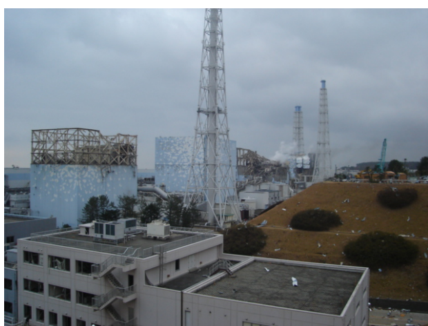
図1-1 事故後の福島第一原子力発電所 （左から1、2、3、4号機） 平成23年3月15日撮影
