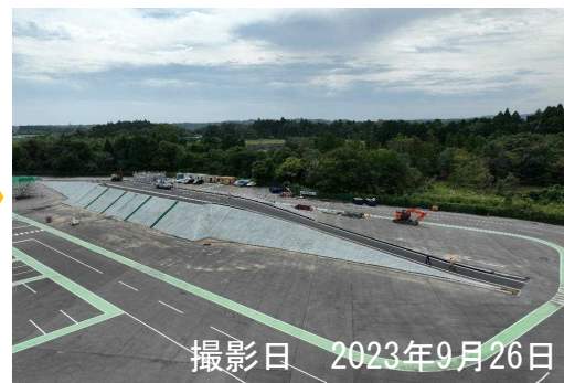
路面排水・舗装・法面工
