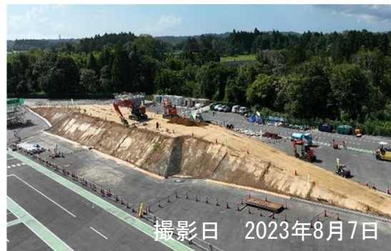
路床盛土工（覆土）
