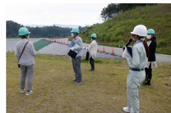
大熊工区 土壌貯蔵施設
