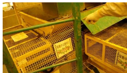
可動部へのネット敷設状況
