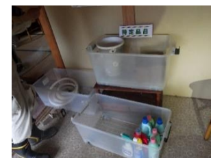
家屋解体作業現場での水銀使用製品など特定品目の分別
