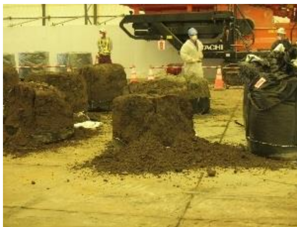
土のう袋取り外し後状況
