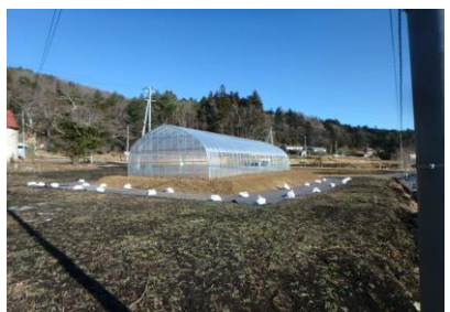
ハウス外側完成
