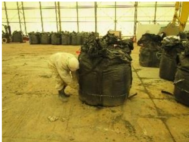
土のう袋の底部をカット
