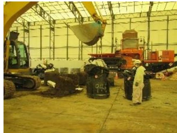
バックホウ吊上げによる土のう袋外し
