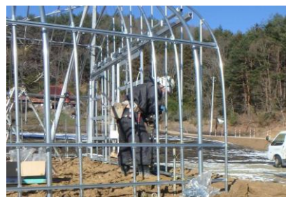
1m堀削し骨組の挿入
