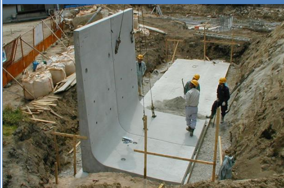
プレキャストL型擁壁工法
