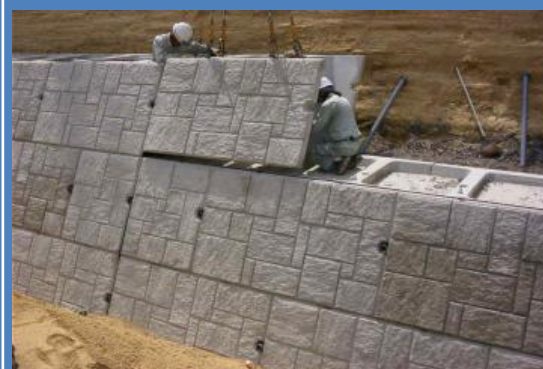
大型ブロック積工法
