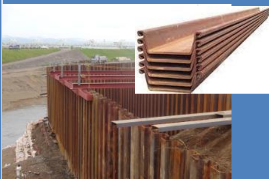
鋼矢板遮断壁 入工法
