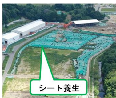
シート養生状況
