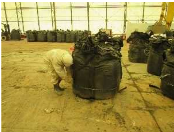
土のう袋の底部をカット
