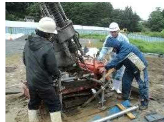
3.土壌カブリング・パイプ挿入 (6月12～14日)
