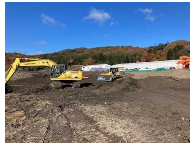
盛土状況(R3.10.29撮影)
