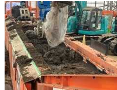
破袋後の土壌の取り出し
