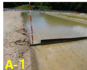
入替え厚さ(北側30cm、南側45cm)の仕切り板
