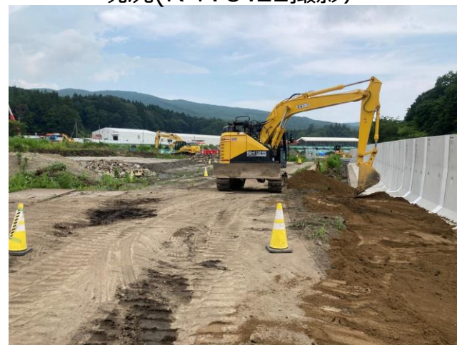
盛土状況(R4.8.9撮影)
