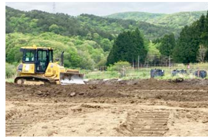
盛土中の再生資材
