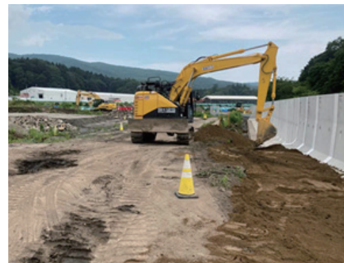
盛土の状況(2工区)
