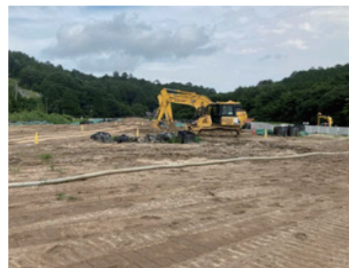
盛土の状況(3工区)
