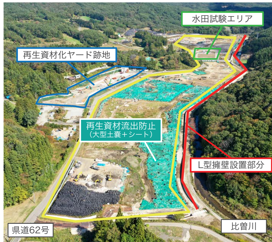
2工区全域の現状(令和4年10月撮影)
