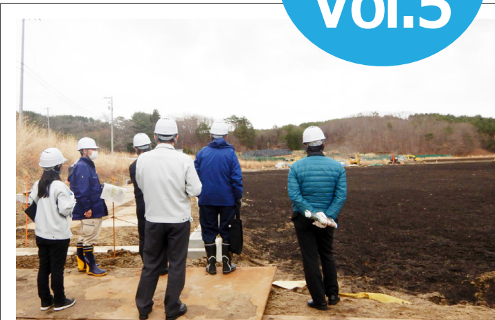
4工区にて盛土の状況を確認している様子
