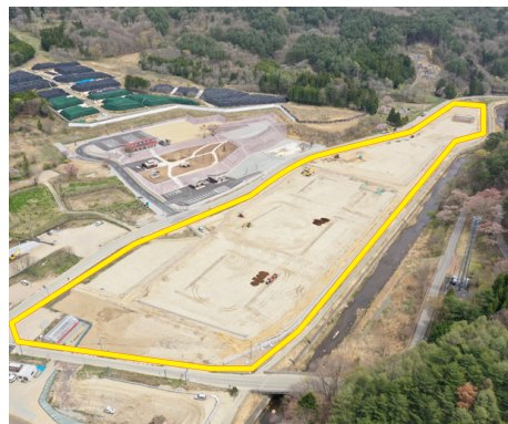
3工区(令和5年4月撮影)
