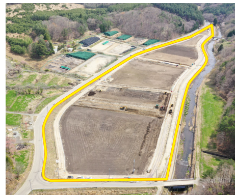
4工区(令和5年4月撮影)
