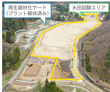
2工区(令和5年4月撮影)
