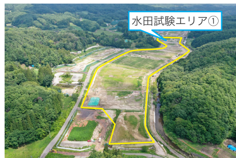
2工区(令和5年8月撮影)
