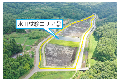
4工区(令和5年8月撮影)
