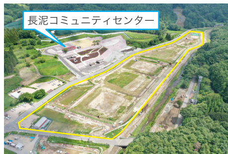
3工区(令和5年8月撮影)
