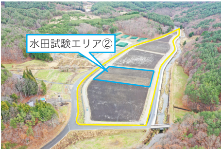
4工区(令和5年11月撮影)
