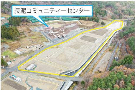
3工区(令和5年11月撮影)
