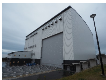
楢葉遠隔技術開発センター 試験棟
