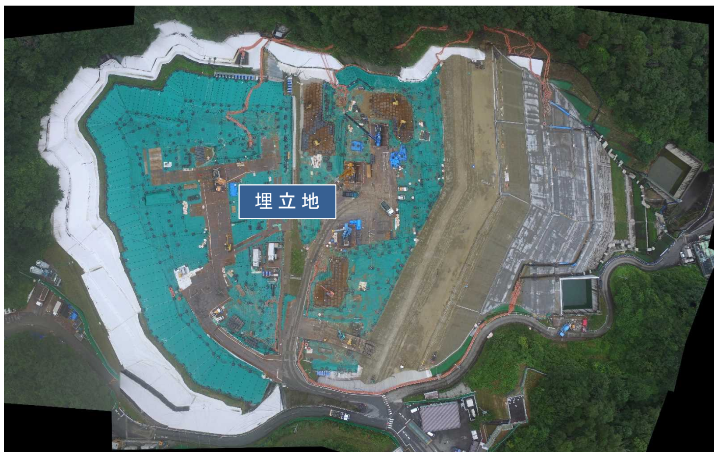
特定廃棄物埋立処分施設 （2020年7月16日撮影）
