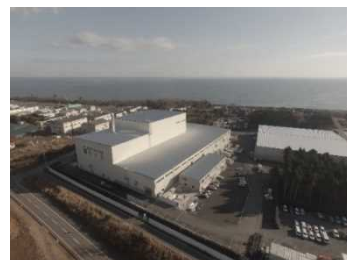
大熊町の仮設焼却施設
