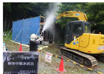
被災家屋等の解体の様子
