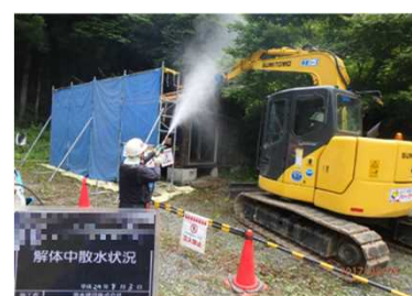
被災家屋等の解体の様子
