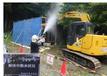
被災家屋等の解体の様子
