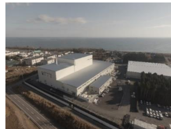
大熊町の仮設焼却施設
