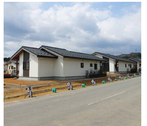
建設が進む公営復興住宅
