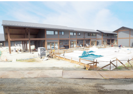
建設中の「駅西住宅」
